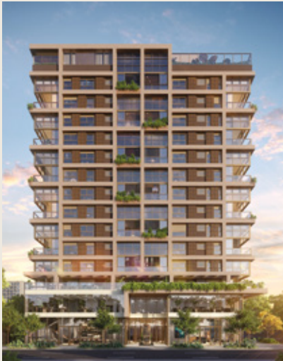
ArtStone Itaim - Em obras
