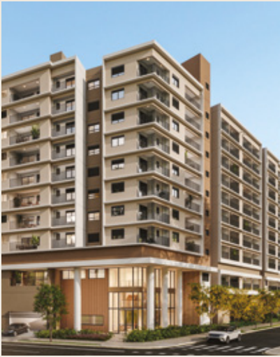
Edro e Trya Mooca - Em obras
